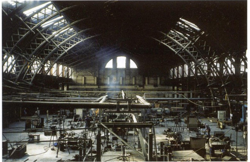
Ein architektonisches Denkmal – die Produktionshalle der Glashütte Lamberts mit ihrer filigranen balkengetragenen Dachkonstruktion. Die Halle wurde im 19ten Jahrhundert für eine Landwirtschaftsausstellung in Nürnberg entworfen und gebaut. 1907 wurde sie nach Waldsassen „verlegt“.
