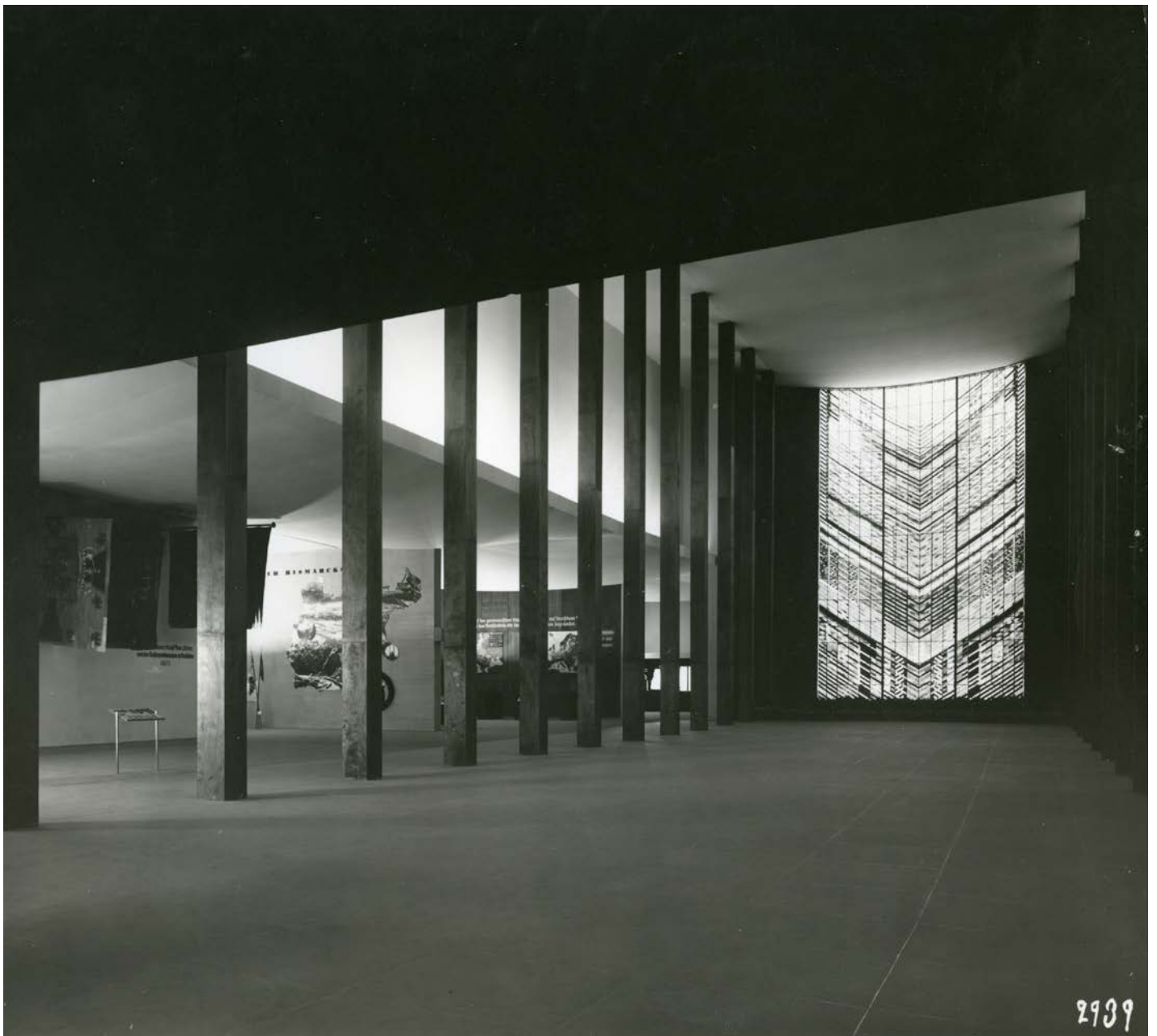
Als Eingangsbereich in eine „Leistungsschau deutscher Arbeit“ konzipiert, führte die vom Bauhaus-Architekten Sergius Riegenberg gestaltete „Ehrenhalle“ durch die Bereiche „Das Reich der Deutschen“ und „Das Deutsche Volk“. Das zentrale Glasfenster von César Klein zeigte einen stilisierten Reichsadler.
